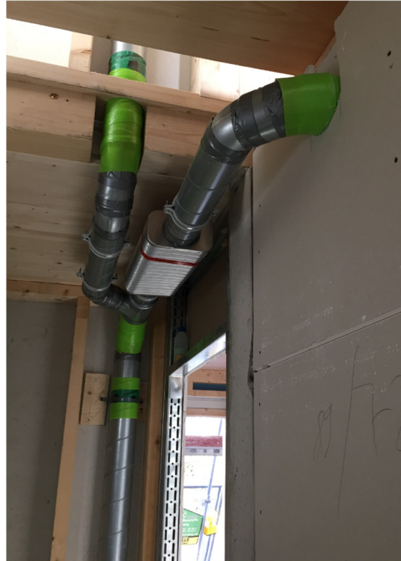
im Kellerabgang (abgeh. Decke folgt)
