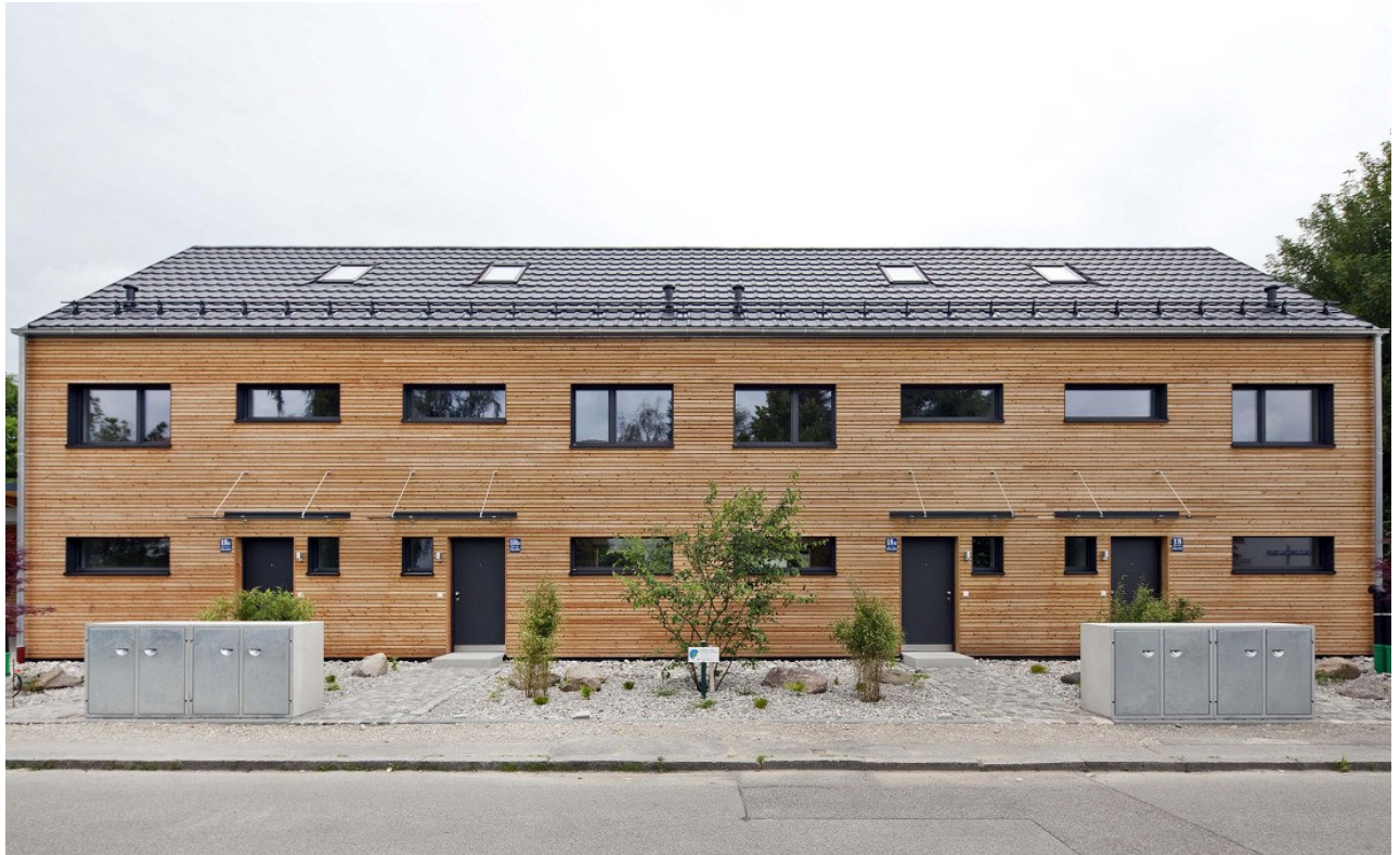
Nordseite – Die Eingangsseite zu den Reihenhäusern
