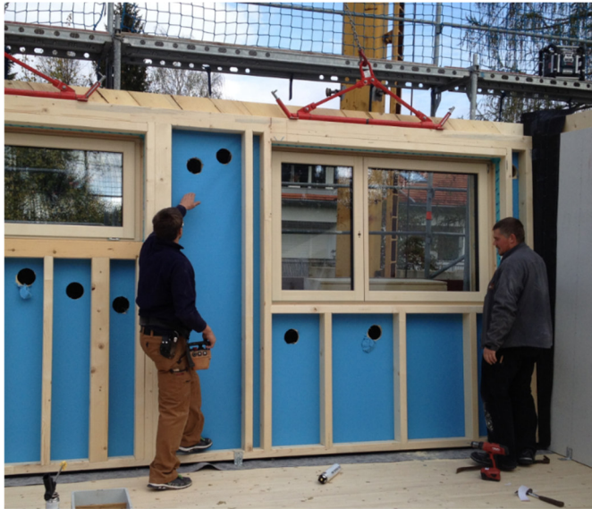
Montage Wand mit eingebautem Fenster
