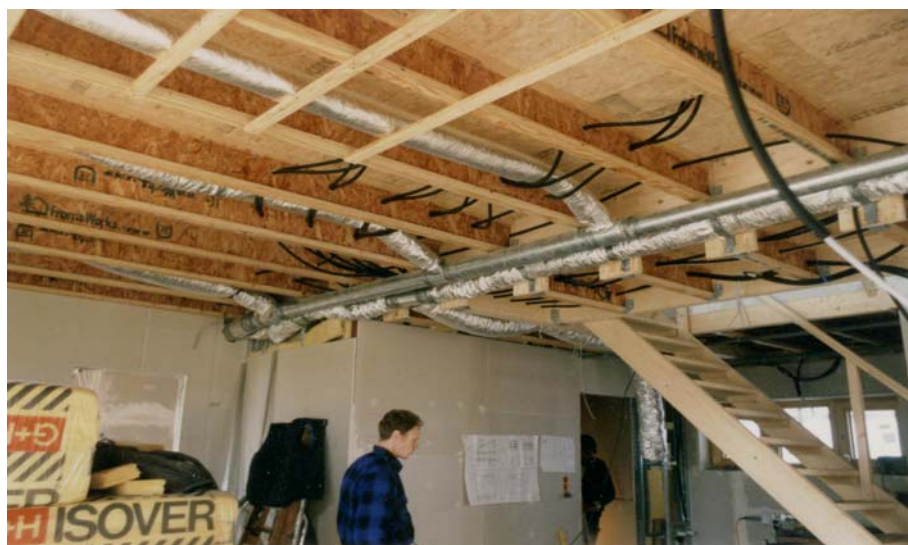
Montage der Lüftungsverrohrung
