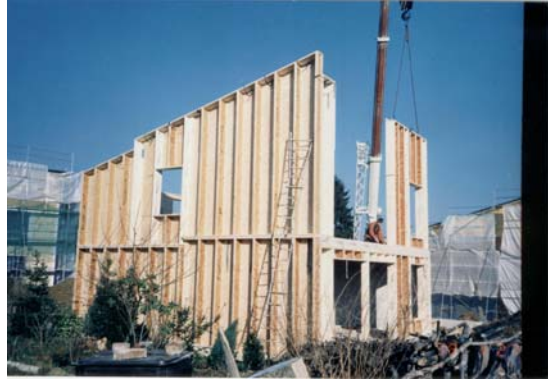
TJI-Stegträger-Konstruktion nach neuem statischen Konzept und mit neu entwickelten Verbindungsdetails und in Vorfertigung (Fotos: MB)
