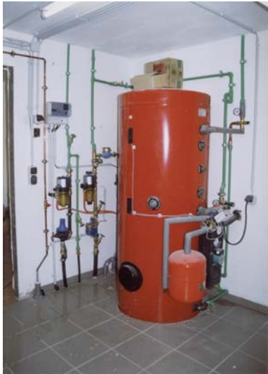
Solaranlage Warmwasser-Solarspeicher, Leitungsführung durch Bodenplatte (Luftdichtigkeit) (Foto: MB)
