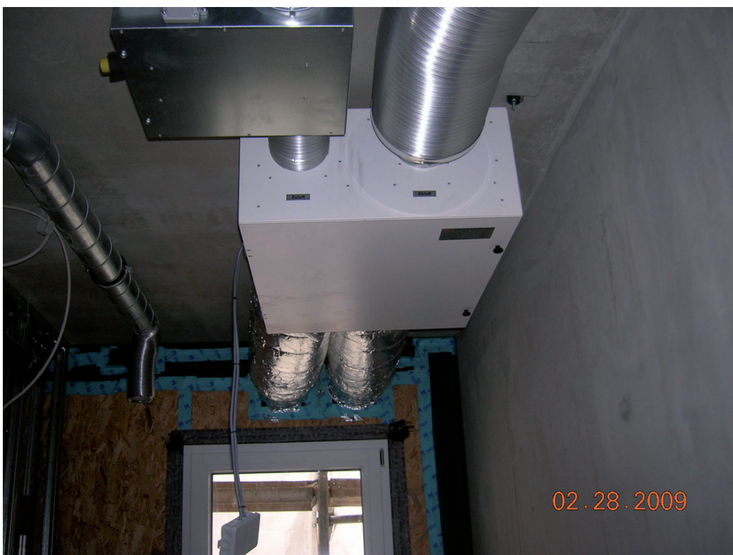
21. Einbau Lüfter mit Nachheizregister im Badezimmer
