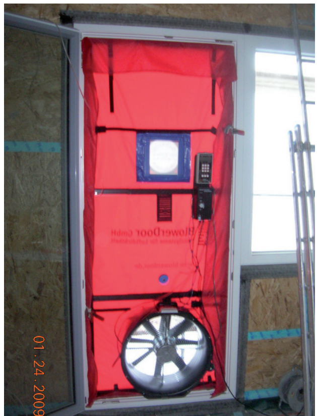
20. Blower Door in Balkontüre
