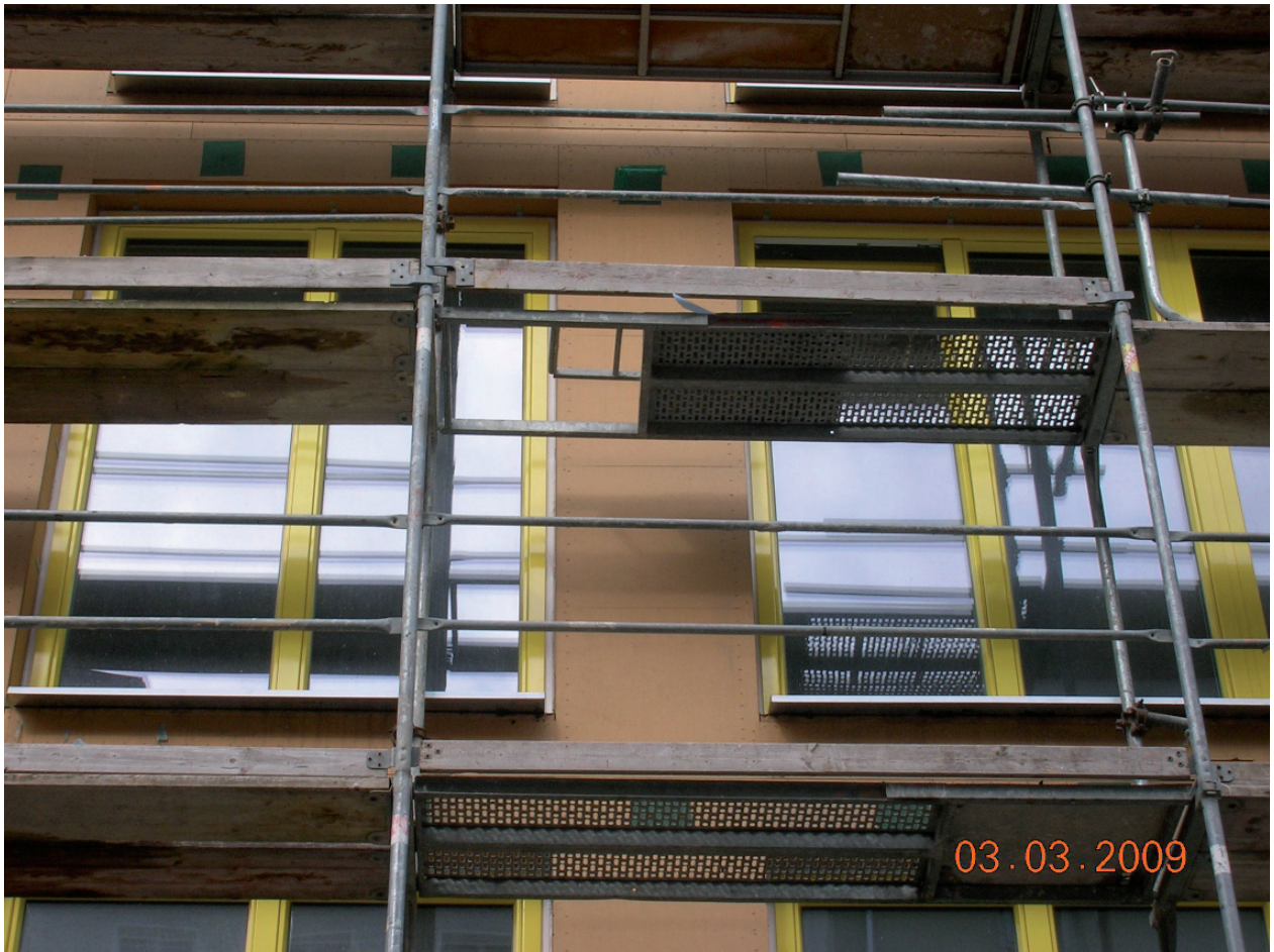
18. Fenster vor Einbau der äußeren Dämmung
