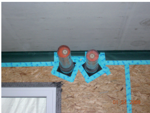
19. Abdichten der Lüftungsrohre im Rohbau
