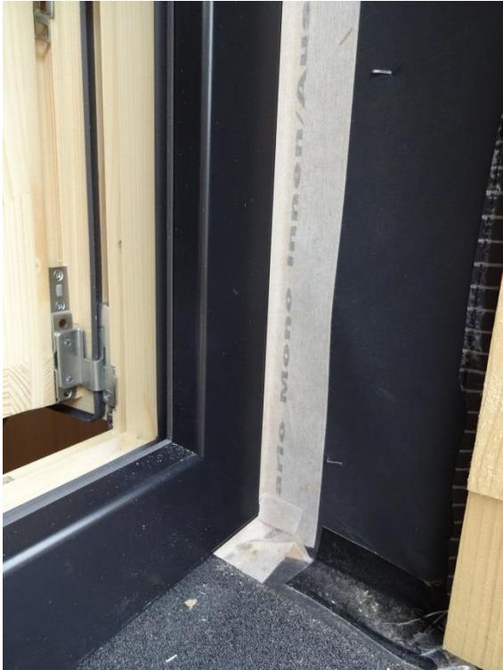
Studierenden-Wohnheim mineroom, Fensterleibung Außen. Der Fensterrahmen wurde Außen 5,0cm tief mit einer Holzfasersplatte überdämmt (Fotos: aap.architekten)
