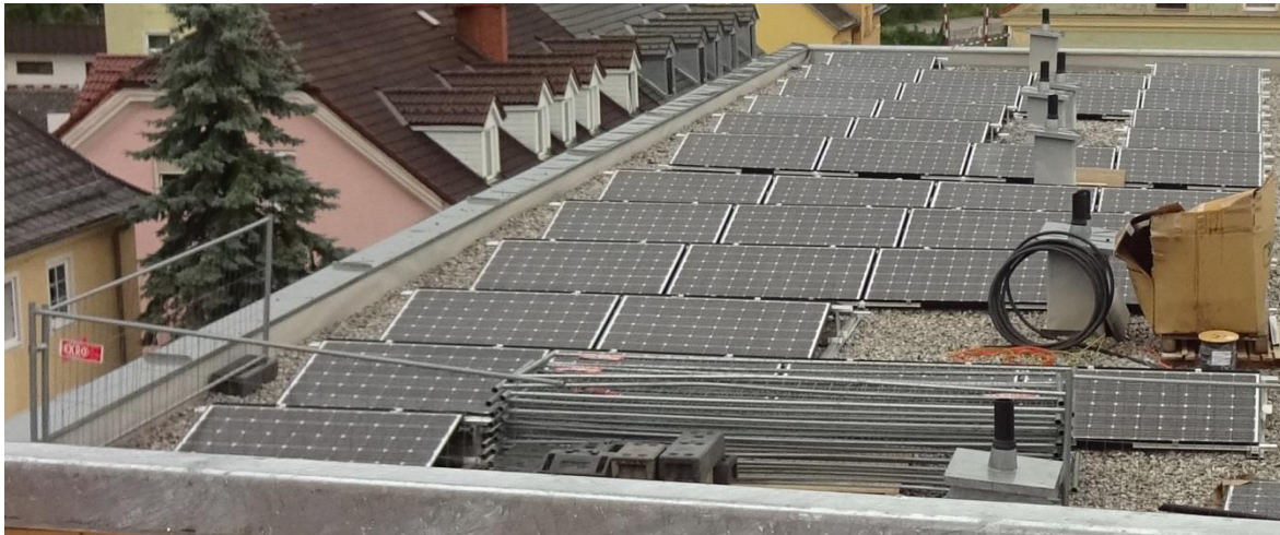
Studierenden-Wohnheim mineroom, Attika fertiggestelltes Dach. (Foto.: aap.architekten)
