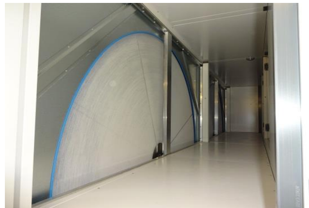
Studierenden-Wohnheim mineroom, Lüftungsgerät TROX X-CUBE und Rotationswärmetauscher. (Fotos: aap.architekten)
