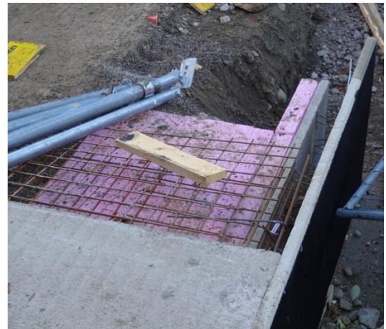
Studierenden-Wohnheim mineroom Detailplan Sockel und Fotos der Ausführung Dämmung unter der Bodenplatte. (Abb. und Fotos aap.architekten)
