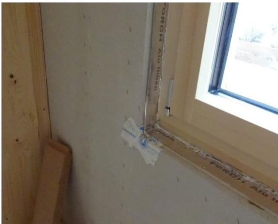
Studierenden-Wohnheim mineroom, Fensterleibung Innen. Abklebung des Fensterrahmens (Foto: aap.architekten)
