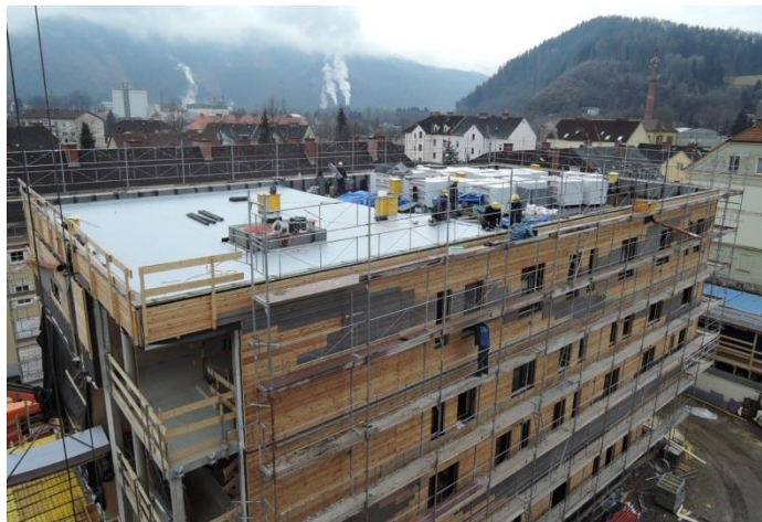
Studierenden-Wohnheim mineroom, Aufbringen der Dachdämmung.
