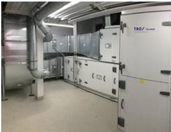
Studierenden-Wohnheim mineroom, Lüftungsgerät TROX X-CUBE und Rotationswärmetauscher. (Fotos: aap.architekten)
