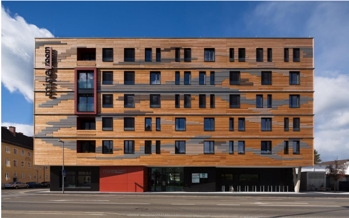
Studierenden-Wohnheim mineroom, Ansicht Josef-Heißl-Straße. Das eingerückte Stahlbeton-Sockelgeschoss mit Plattenverkleidung und Haupteingang ist gut ablesbar (Foto: J. Konstantinov).
