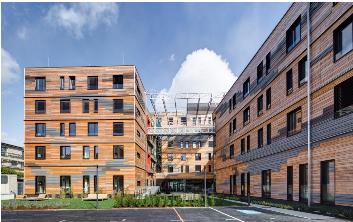
Studierenden-Wohnheim mineroom, Ansicht West Blick in den Innenhof. Die Stahlkonstruktion die über den Hof gespannt ist trägt Sonnenschutzsegel, die im Hochsommer die Innenhoffläche teilweise beschatten. (Foto: J. Konstantinov).
