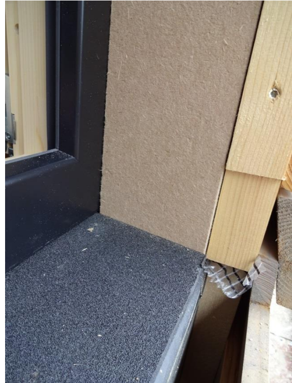
Studierenden-Wohnheim mineroom, Fensterleibung Außen. Der Fensterrahmen wurde Außen 5,0cm tief mit einer Holzfasersplatte überdämmt (Fotos: aap.architekten)
