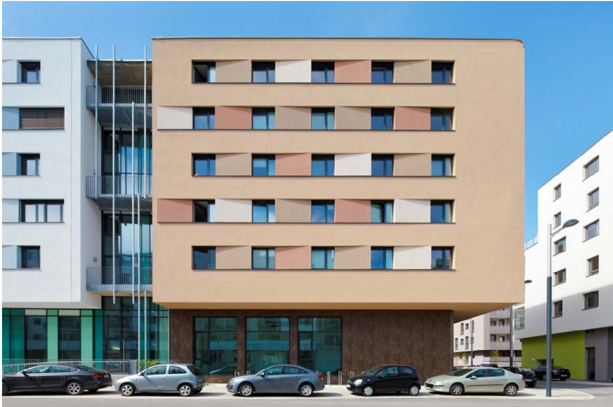
Studierenden-Wohnheim GreenHouse, Außenwände fertig verputzt. Die Schräge der Leibungen verleiht durch ihren Schattenwurf der Fassade Plastizität. (Foto: aap.architekten).
