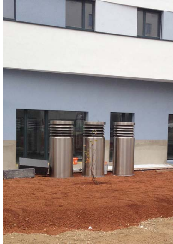
Studierenden-Wohnheim GreenHouse, links Fortluftöffnung im ersten Untergeschoss, rechts Frischluftbrunnen. (Fotos aap.architekten)
