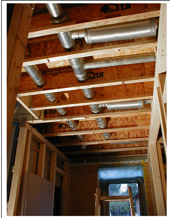
Lüftungsleitungen in der Decke
