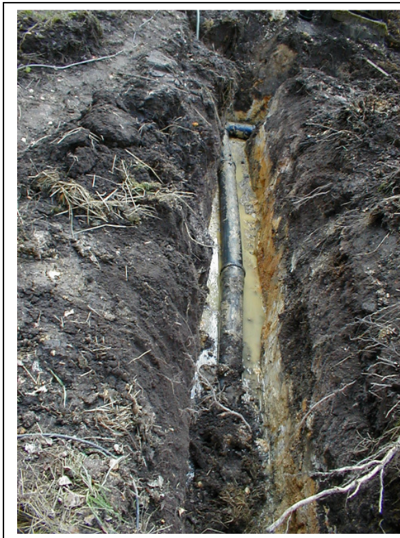
Erdwärmetauscher
