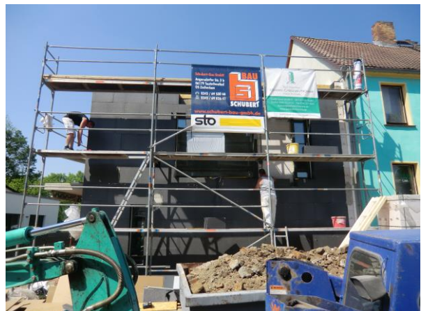
Fassade mit WDVS
