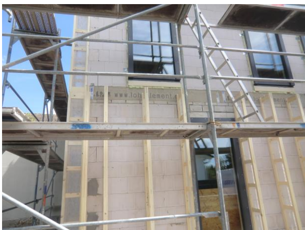
Stegträger als Fassadenunterkonstruktion
