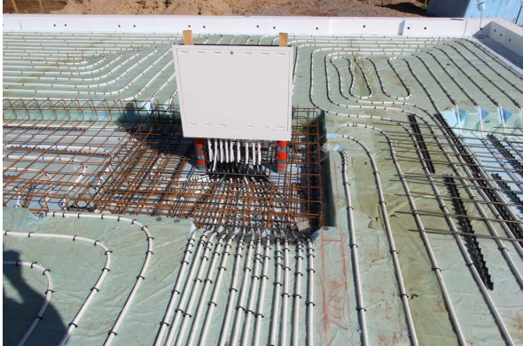
2.2. Baustellenfotos - Gründung samt Fußbodenerwärmung in der Sohle
