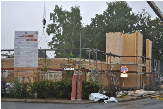
Richtarbeit mit vorgefertigten Holztafelementen
