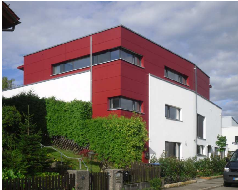
Nord- und Ostfassade nach dem Umbau
