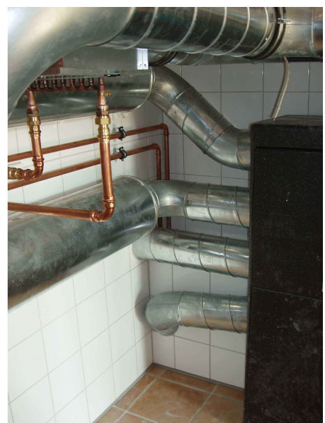
Lüftungsanlage, kurz vor Fertigstellung Bei unseren Bauvorhaben werden Technikraumwände wegen der vielen Rohre grundsätzlich gefliest
