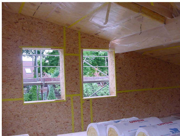
Dachgeschoss im Rohbau
