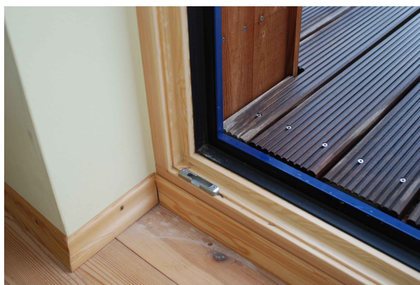
Detail Balkentür an Holzdeck
