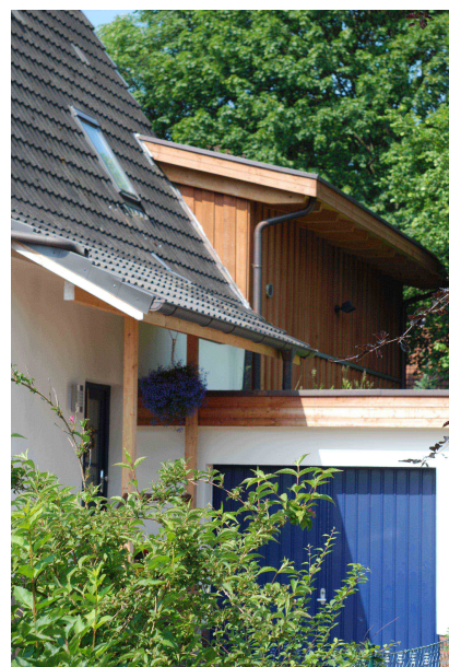
Ost- und Nordfassade
