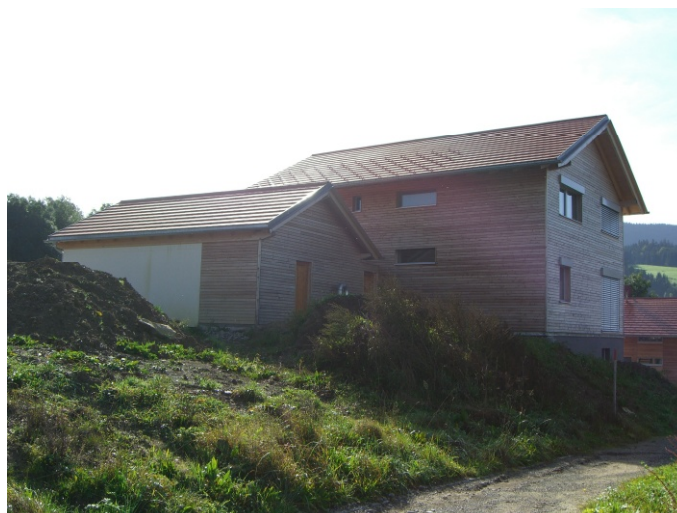
Nordseite Passivhaus Magnestraße in Weitnau.
