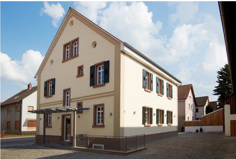
Nord- und Westfassade
