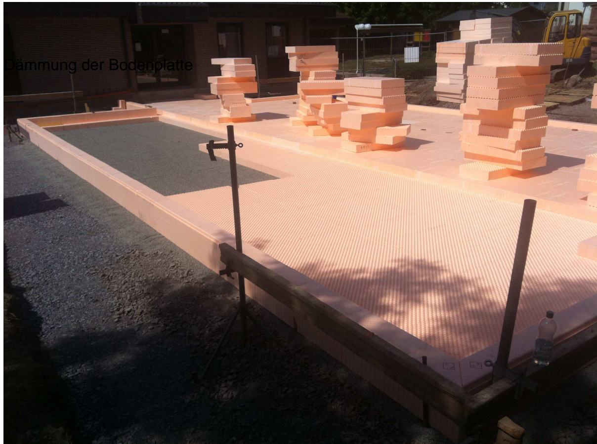
Lastabtragendes Dämmplatte unter der Bodenplatte
