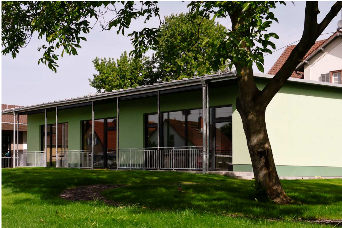
Ansicht von Süden / Osten
