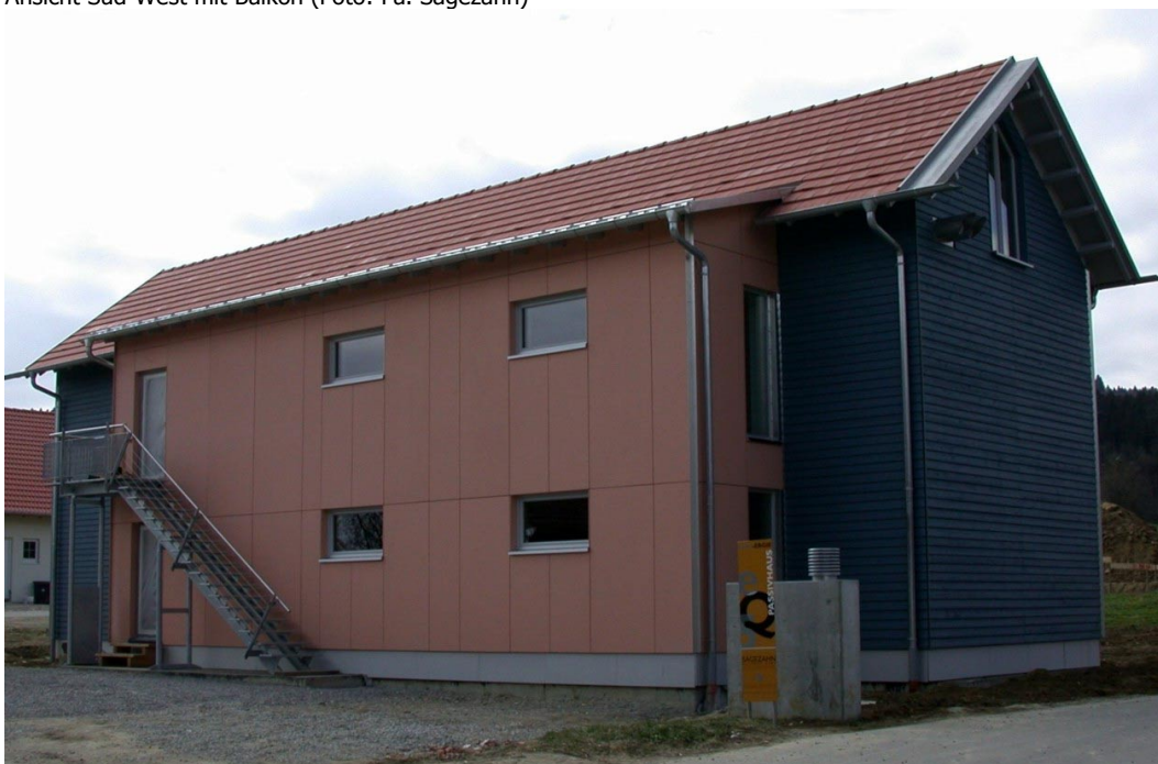
Ansicht Nord-West, -Ost: Eingangsbereich noch ohne Carport (Foto: Fa. Sägezahn)
