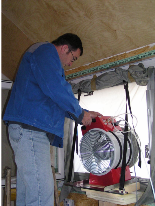
Blower Door Messung (Quelle: Fa. Sägezahn)
