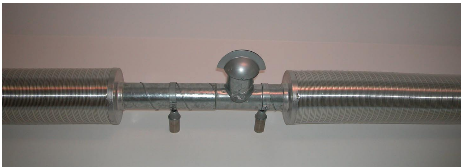
Lüftungsrohre Wickelfalz mit Schalldämpfer sichtbar (Quelle: Fa. Sägezahn)
