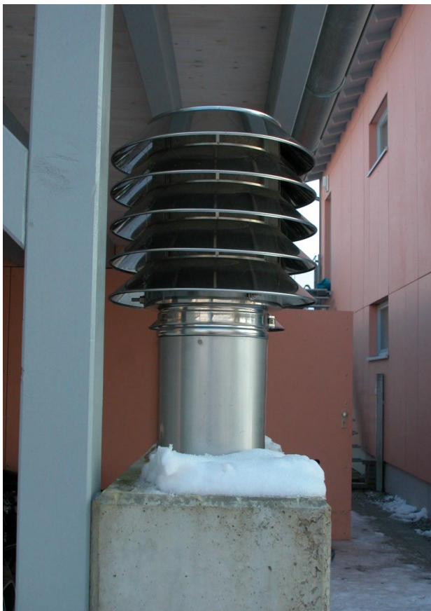
Zentraler Ansaugstutzen für Frischluft (Foto: Fa. Sägezahn)
