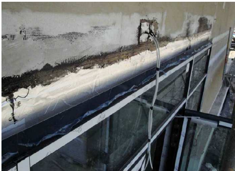
Oberer Anschluss der PR-Konstruktion am Eingang (Windfang)
