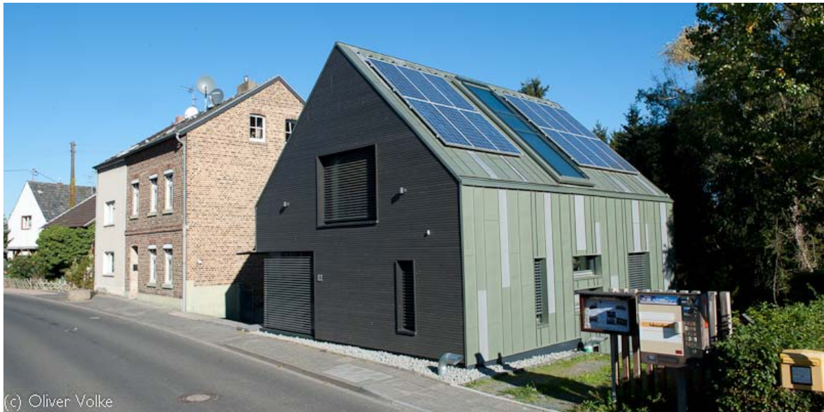
Das nach Osten orientierte Dach ist mit Photovoltaikmodulen bestückt
