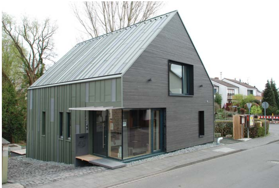
Sanierung zum „echten“ Passivhaus
