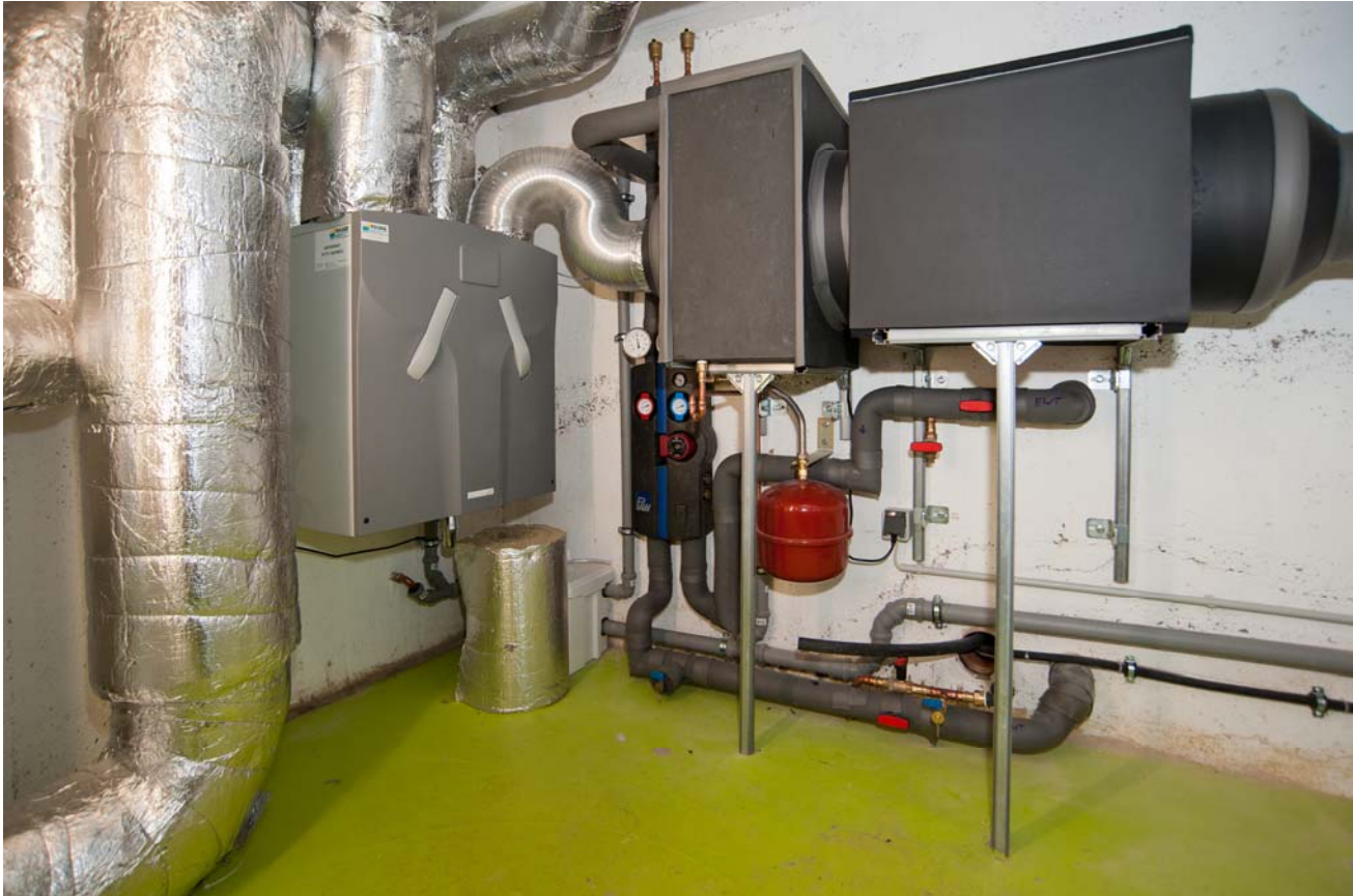
Das Zehnder Lüftungsgerät wurde nachträglich durch ein Drexel-Weiss „Aerosmart Mono“ ersetzt
