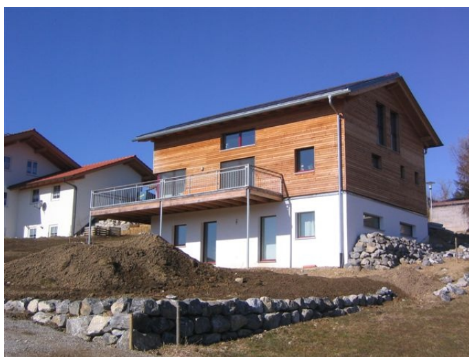
Süd / Ostseite Passivhaus Auf der Egg Steingaden.
