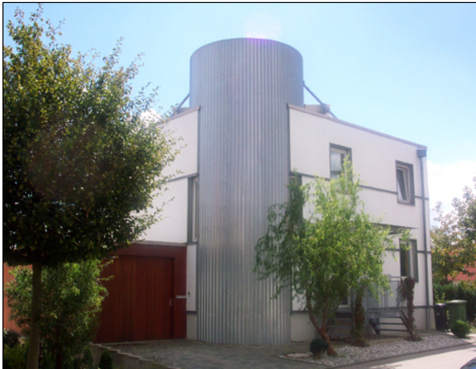
Passivhaus Oehler, Nordseite; mit dem in Wellblech verkleideten Treppenhaus. Daneben ist die Garage mit dem darunter liegenden kalten Keller erkennbar (alle Fotos: Oehler)
