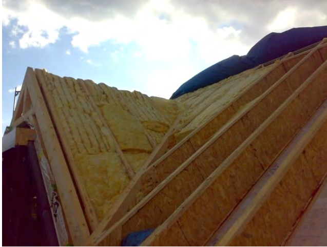
Die Dämmung wird von außen eingebracht.
