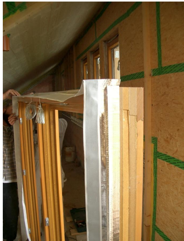
Befestigung des doppelseitigen Klebebandes am Fenster vor dem Einbau
