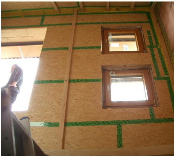
Luftdichter Anschluss der Dampfsperrbahn im Kinderzimmer, Wandheizfläche
