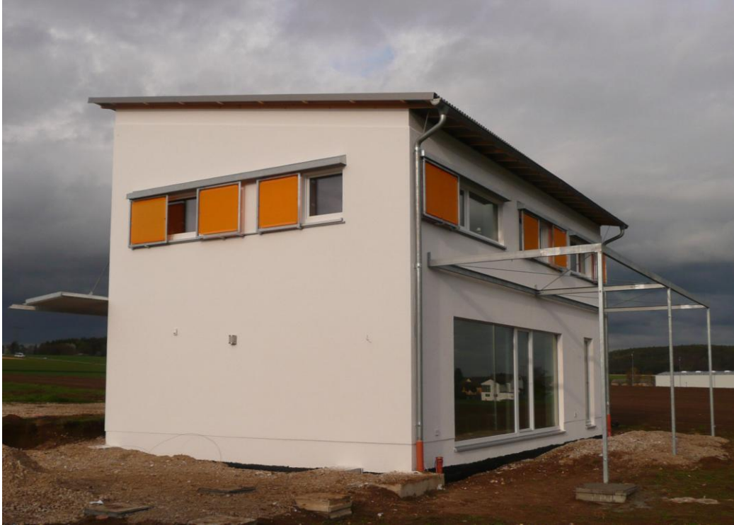
Westseite Passivhaus Adelschlag mit Schiebeläden und Pergola im Süden (Foto: Regner)
