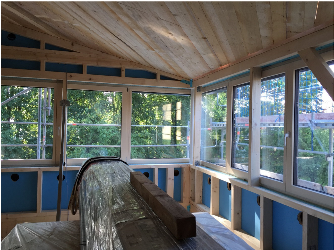
Innenansicht Eckverglasung Alu2Holz
