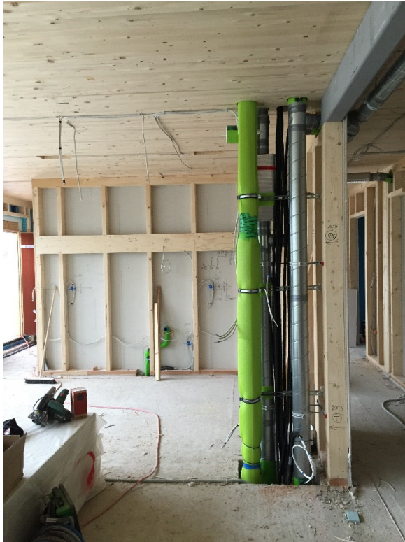
Steigleitungen im unverkleideten Haustechnikschacht im EG und OG
