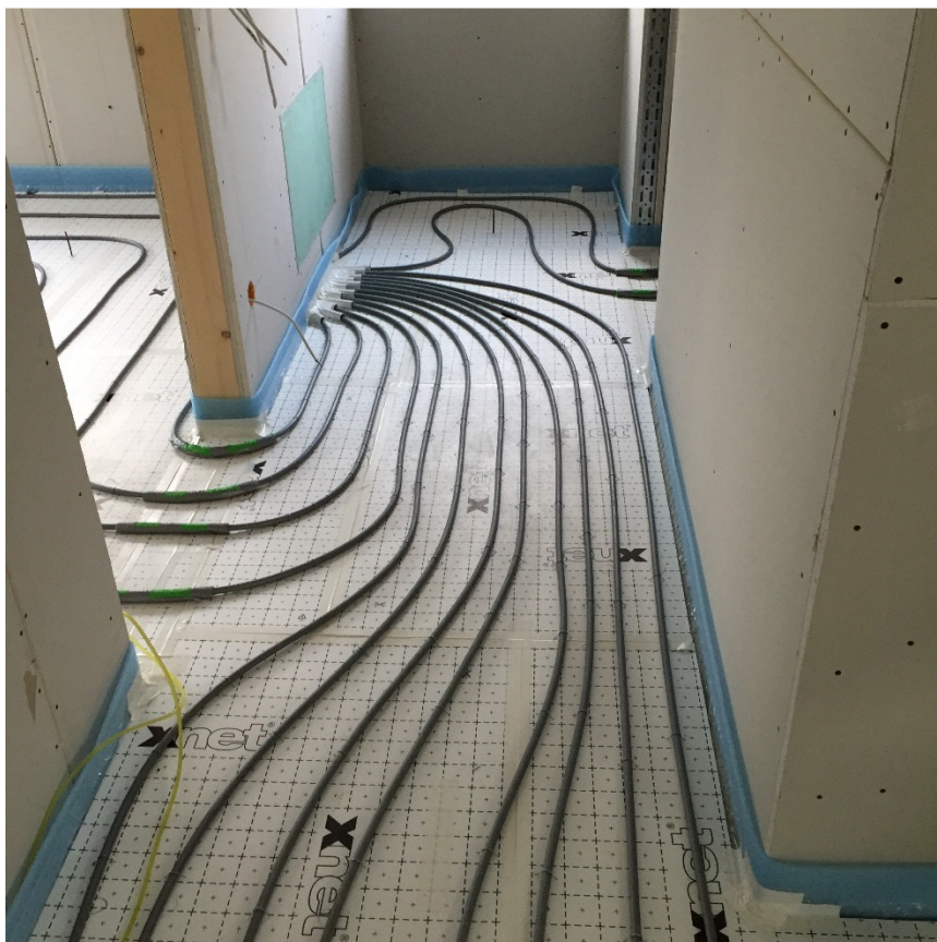
Fußbodenheizungs- verteilung EG
