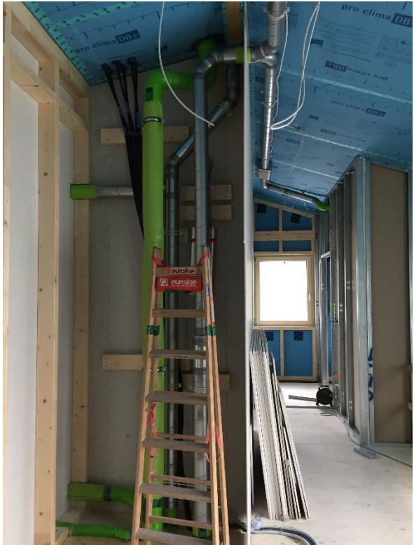
Kanalführung mit Schalldämpfer im EG und OG (abgeh. Decke folgt)
