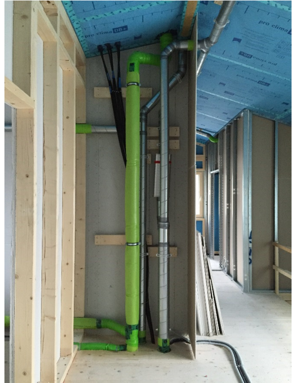
Steigleitungen im unverkleideten Haustechnikschacht im EG und OG
