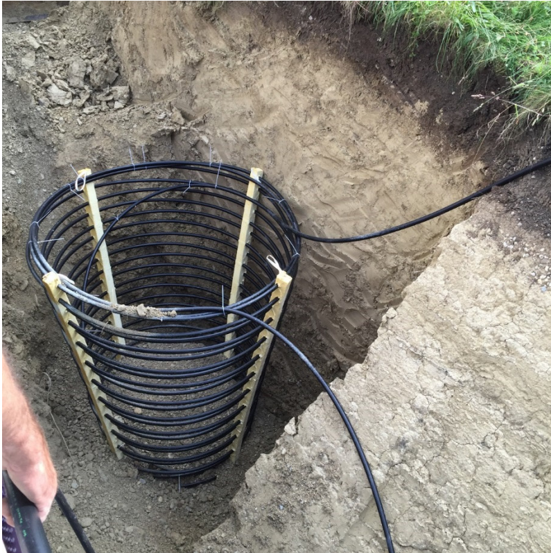
Einbau Erdwärmekorb für den Sole-Kreis
