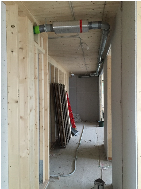
Kanalführung mit Schalldämpfer im EG und OG (abgeh. Decke folgt)
