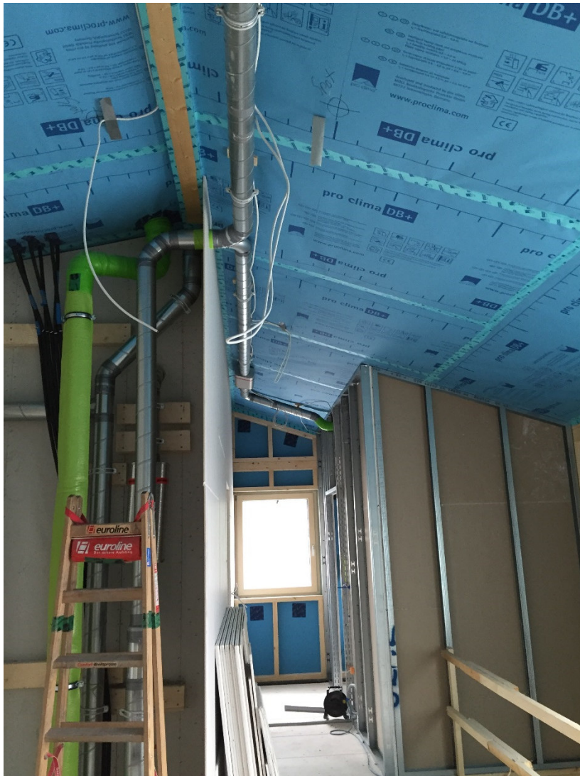
Blick ins OG Dampfsperre
