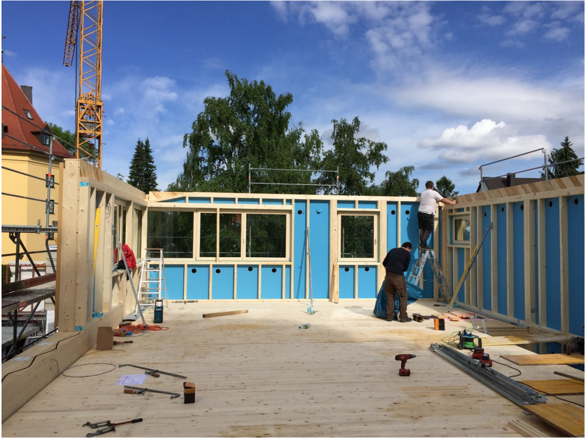
Wandmontage OG mit eingebauten Alu2Holz Fenstern
