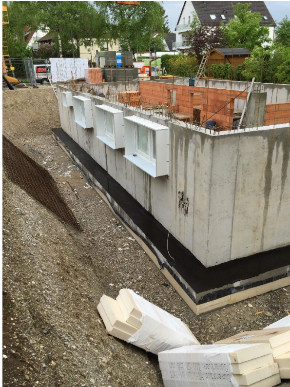
Keller Rohbau – Überstand Bodenplatte mit Dämmung und Kellerfenster
