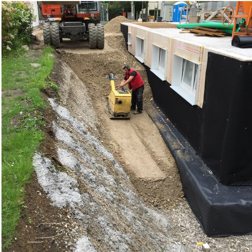
Keller Rohbau – Überstand Bodenplatte mit Dämmung und Kellerfenster
