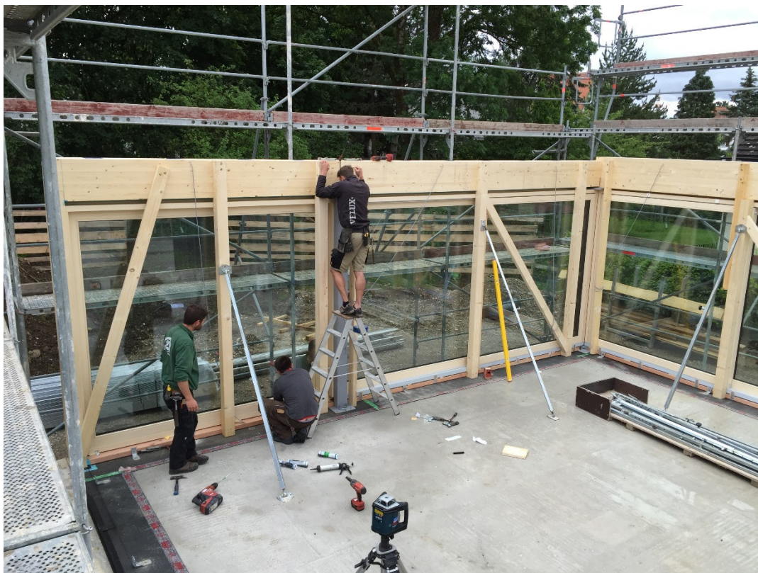
Montage Außenwand EG mit eingebauten Hebe-Schiebetür-Elementen
