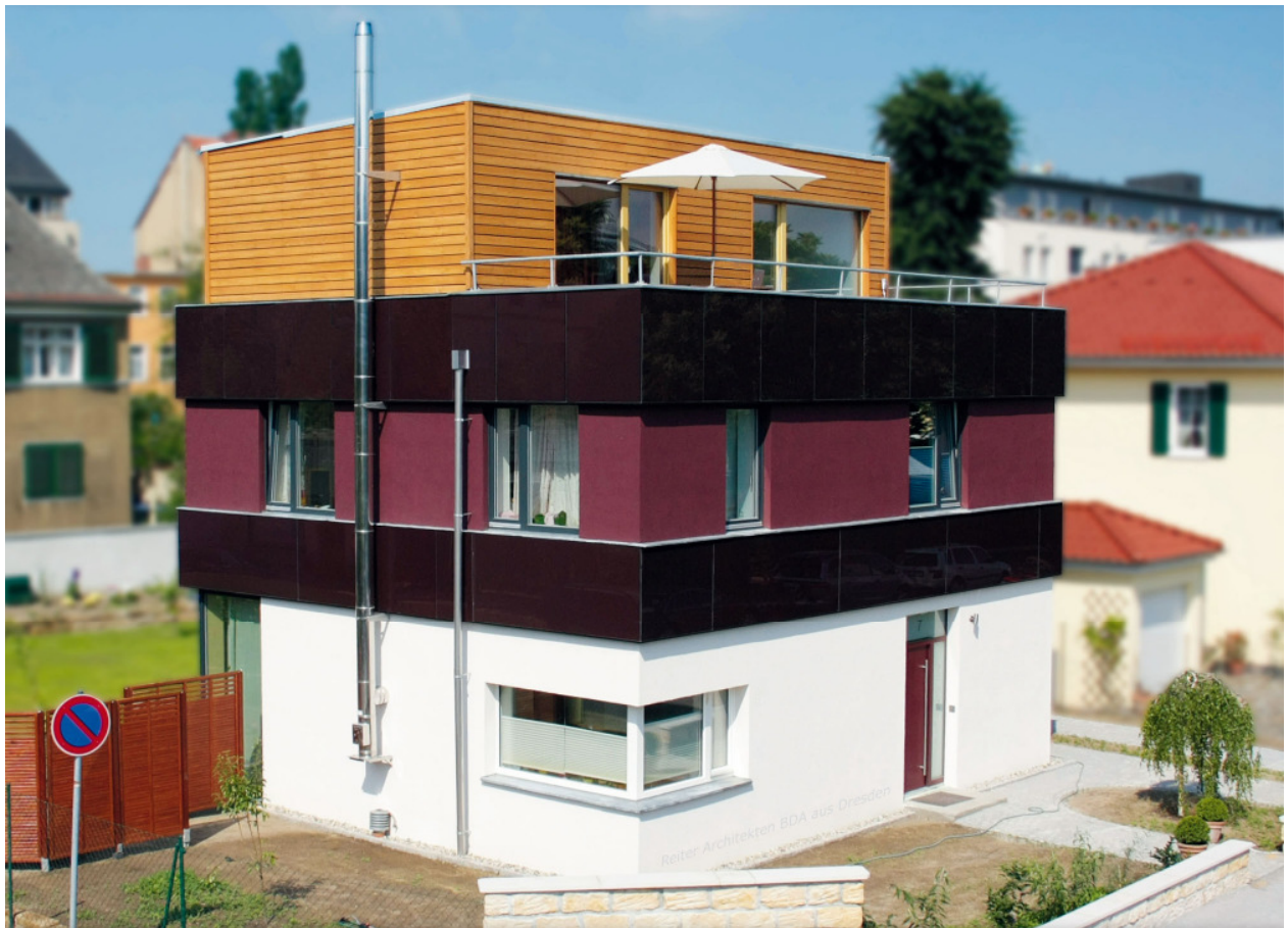
Nord-Ost-Seite. Straßenseite, Photovoltaikmodule an Fassade im 1. Obergeschoss (Quelle: Ökowerk Massivhaus GmbH)
