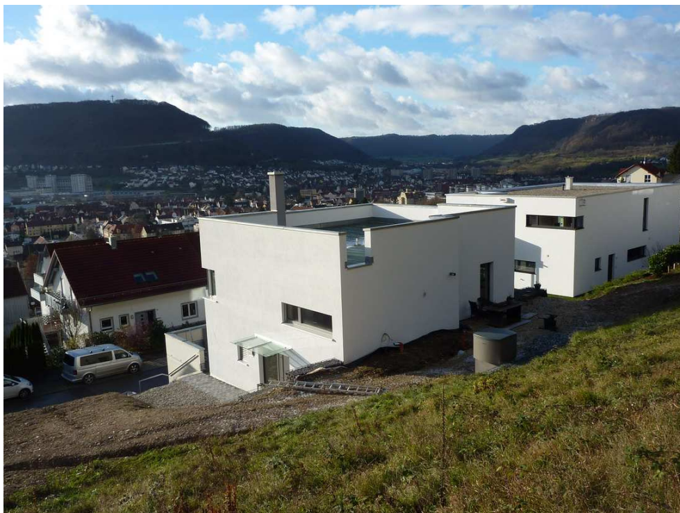
Ansicht NO - mit Blick über die Dachterrasse in das Filstal. Hangseitig ist die Luft-Wasser-Wärmepumpe angeordnet. (Foto: Sawall)
