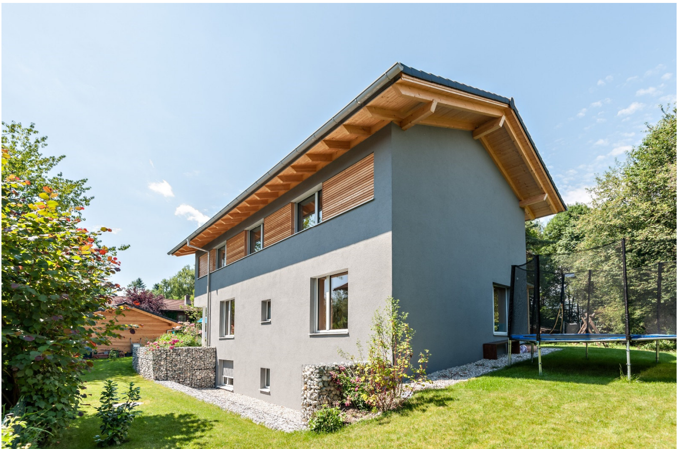
Ostfassade Fenster im Untergeschoss
