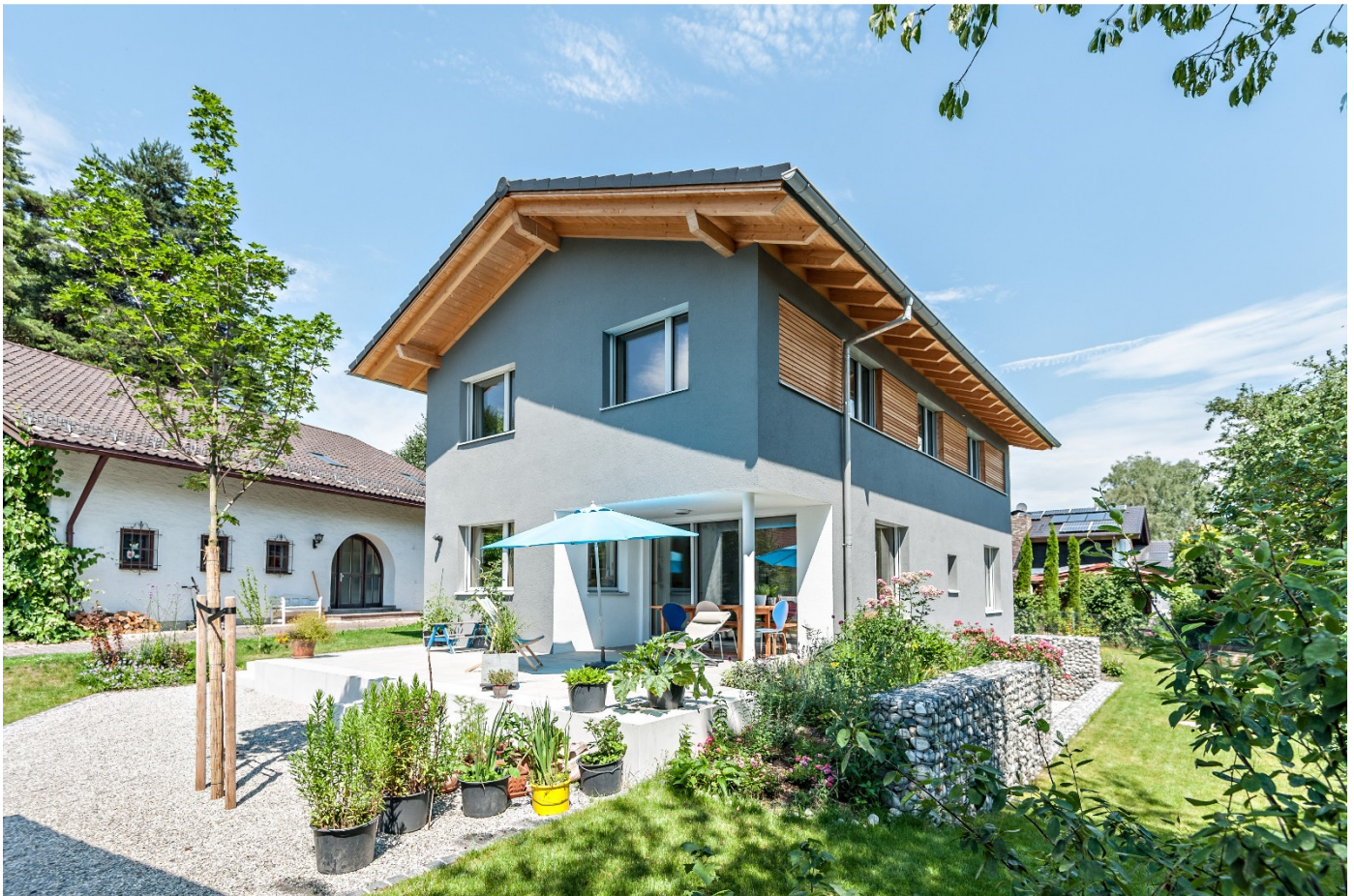
Süd- und Ostfassade mit überdachter Terrasse
