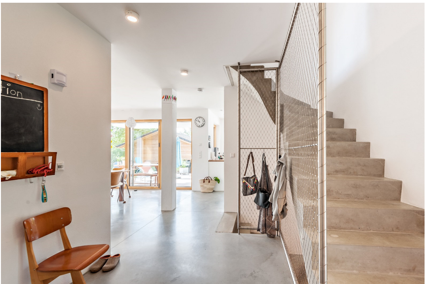
Diele mit Sichtbetontreppe ins Obergeschoss
