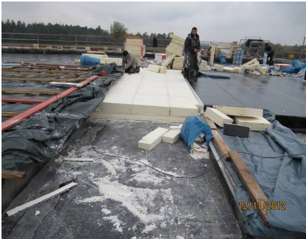
Dach U = 0,10 \text{ W/(m}^2\text{K)} Systemgefälledachdämmung mit Abdichtung (Warmdach) mit Bauder PIR
