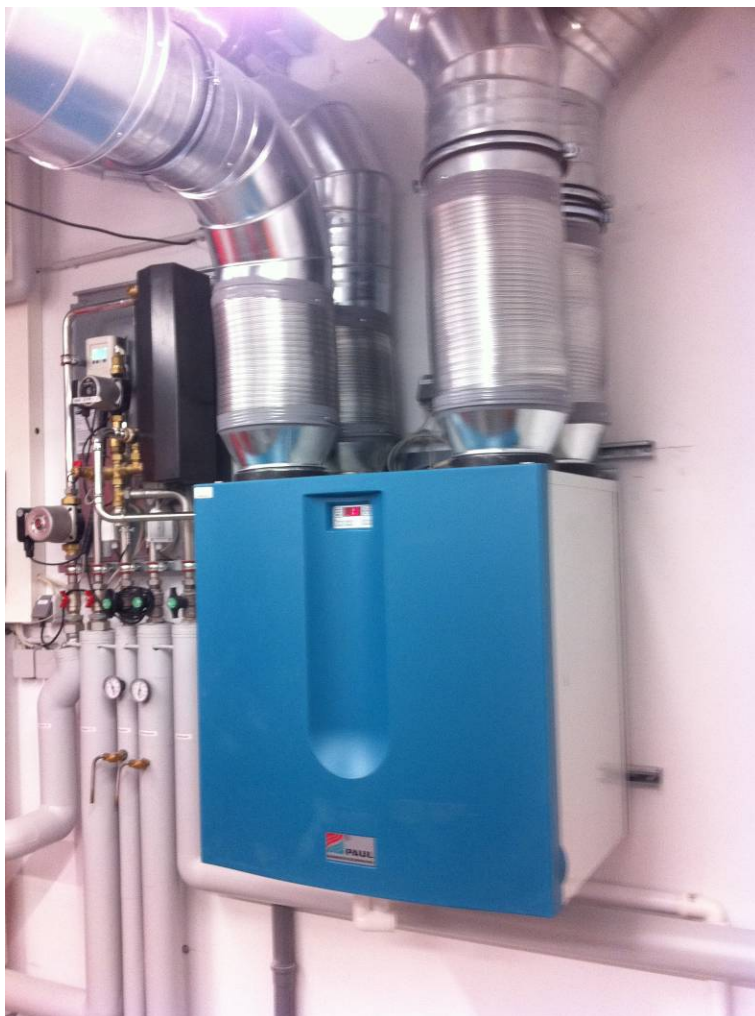
Bild 16: Abbildung Lüftungsgerät Paul Santos
