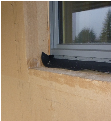
Einbau mit Rahmenüberdämmung
