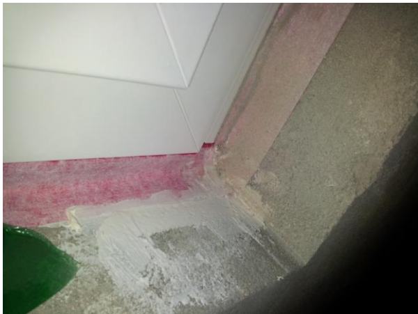
Einbau nach RAL - Montage
