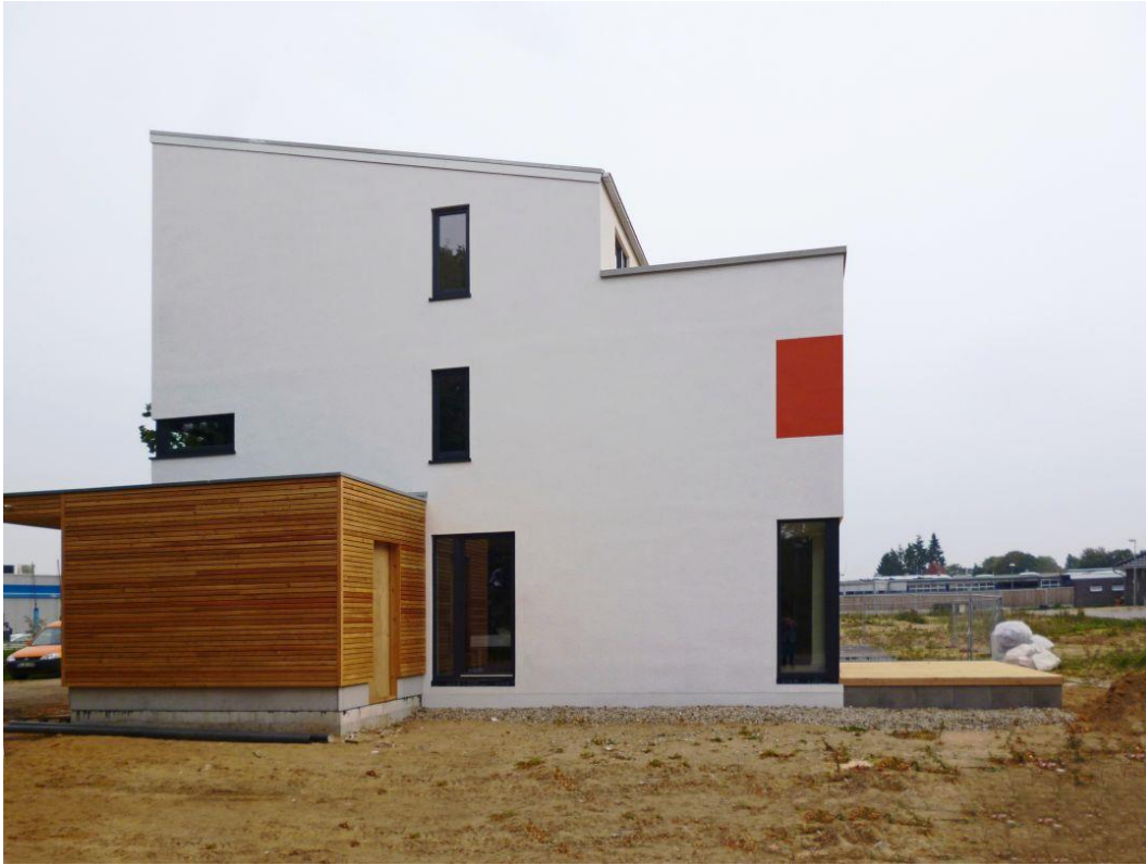
Westseite Passivhaus Grundweg Kaltenkirchen (Foto: Architekturbüro Thyroff-Krause)
