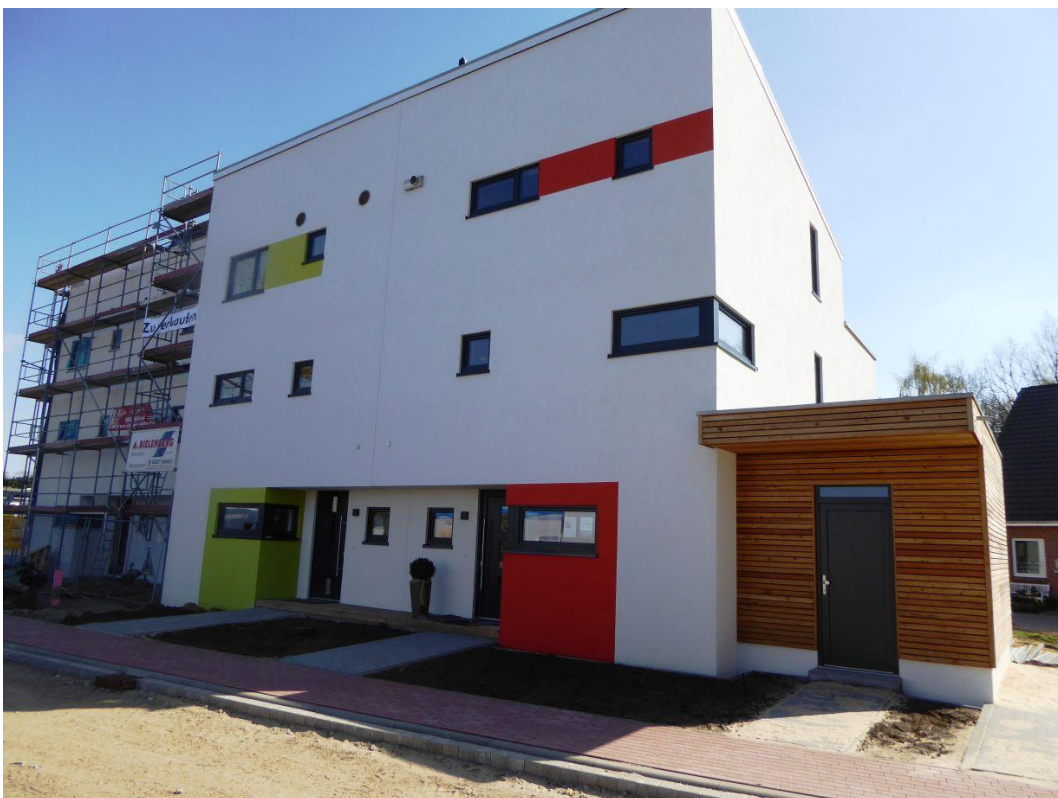
Nordseite Passivhaus Grundweg Kaltenkirchen (Foto: Architekturbüro Thyroff-Krause)
