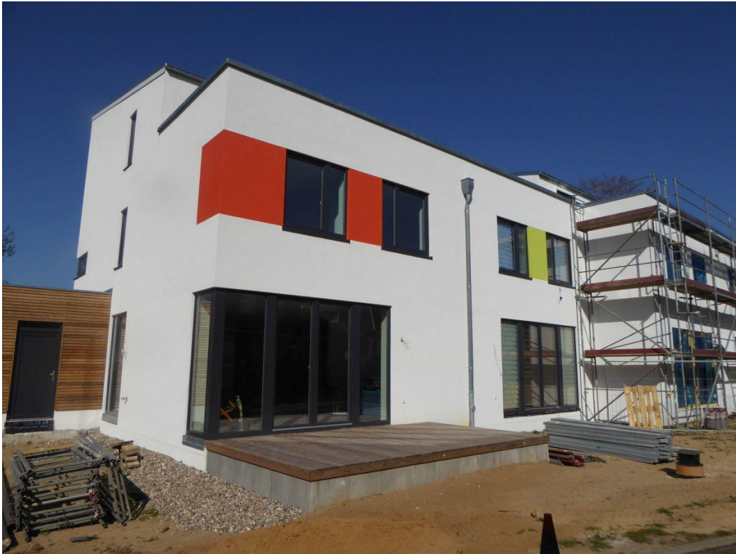
Südseite Passivhaus Grundweg Kaltenkirchen (Foto: Architekturbüro Thyroff-Krause)
