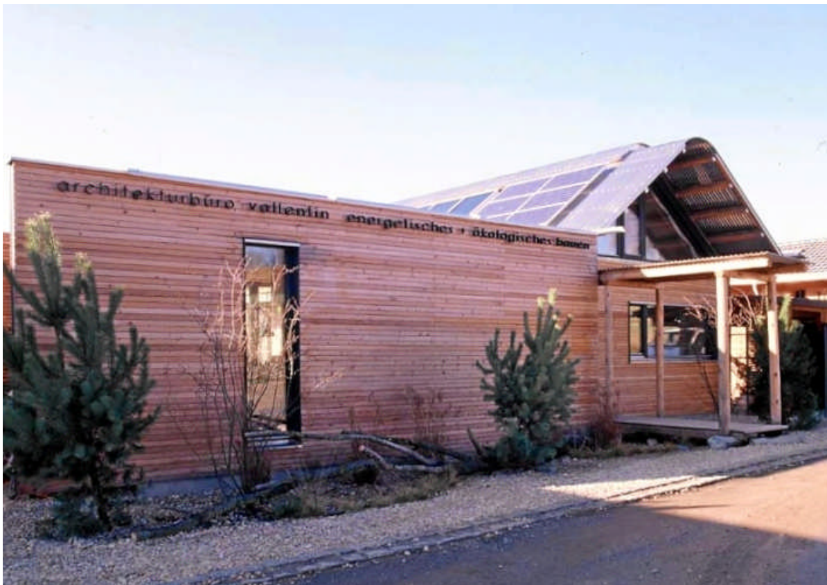
Ansicht von der Straße – Eingang
