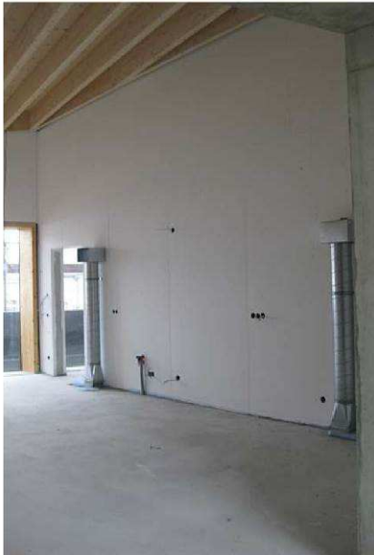
Lüftungsauslässe im MZR
