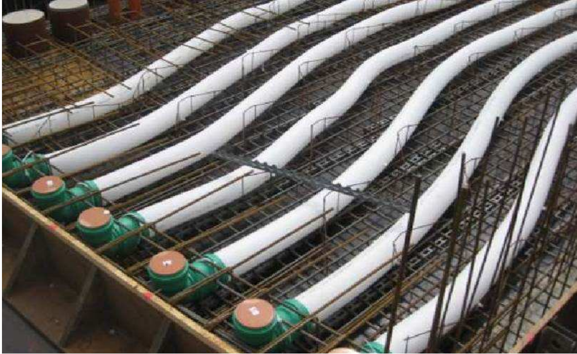
Verlegung der flexiblen Lüftungsleitungen innerhalb der Stahlbetondecken
