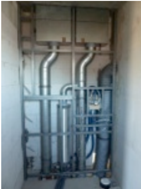
Installationswand der Bauphase
