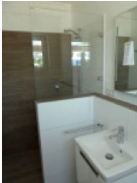
gleiche Wand nach Fertigstellung
