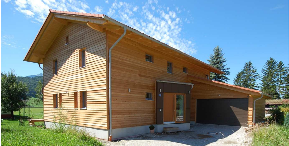
Hier sieht man die Nordostecke mit herausgedrehtem Eingangsvorbau und Garage.
