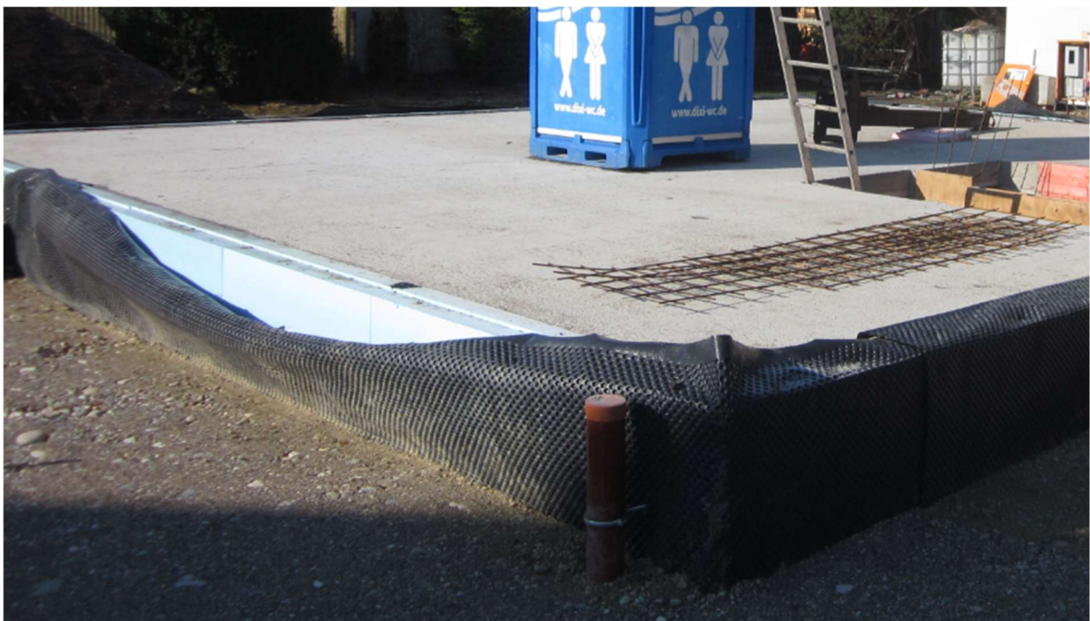
Kelleraußenwand mit 2-lagiger Dämmung und Noppenbahn
