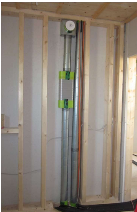
Lüftungsleitungen/Steigleitungen in den Innenwänden
