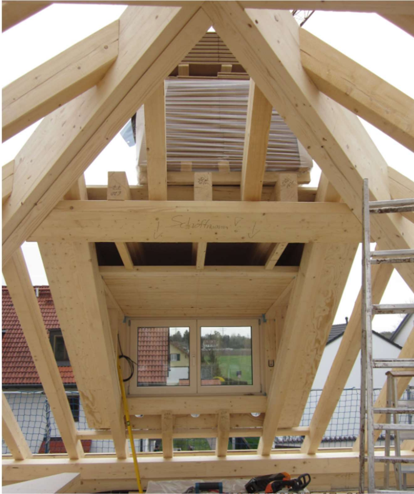
Gaube im Rohbau
