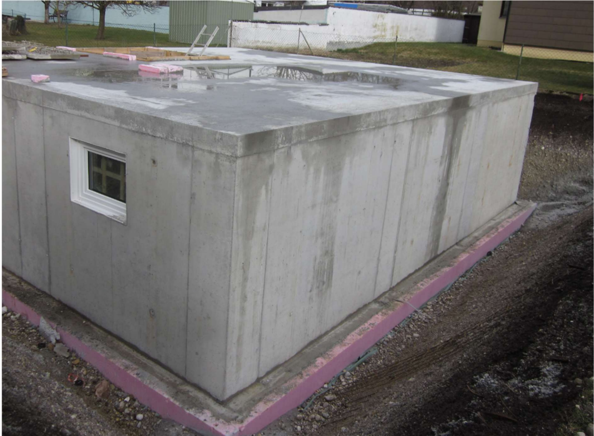
Keller Rohbau – Überstand Bodenplatte mit Dämmung
