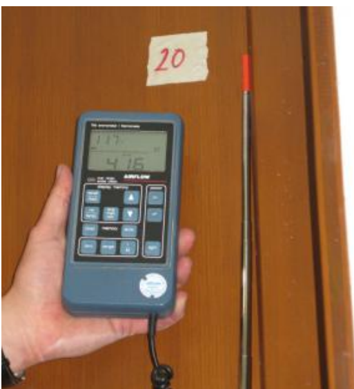
Schließfuge der Türblätter Flur OG Ausgang Balkon Westfassade
