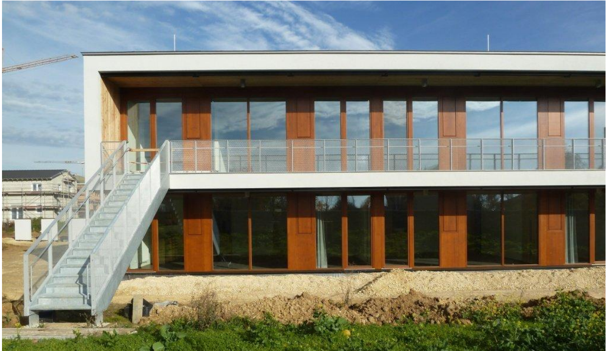
Teilansicht der Südfassade (Foto: D'Inka, Scheible, Hoffmann Architekten BDA)
