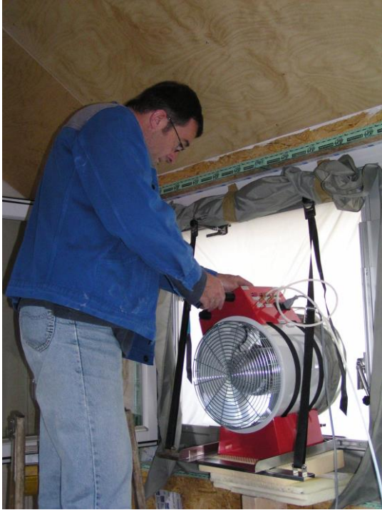
Blower Door Messung (Quelle: Fa. Sägezahn)
