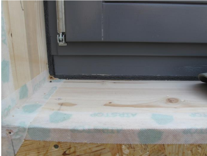
Fensterdetail Einbau mit umlaufenden Butylkautschukband (Quelle: Fa. Sägezahn)
