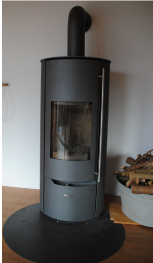
Stückholzofen mit Wassertasche im Wohnzimmer
