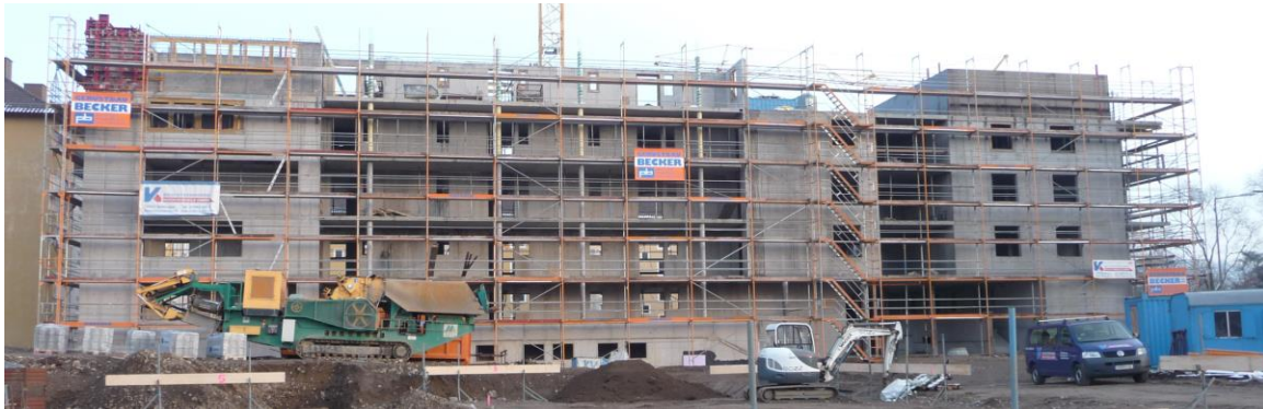
Ansicht Westflügel kurz vor Fertigstellung des Rohbaus. Die Laubengänge sind mittig erkennbar.
