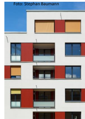
Fassade und Dachkante
