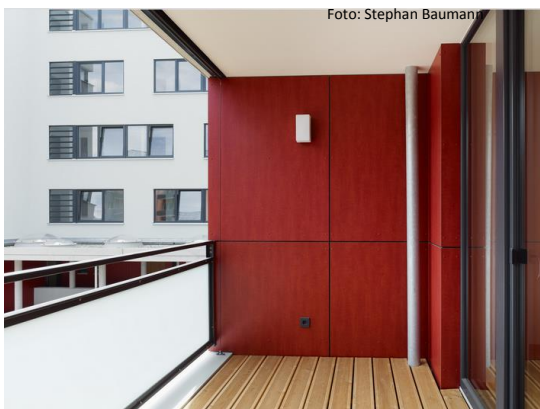
Loggia mit Dielen und wertigen Trennwänden
