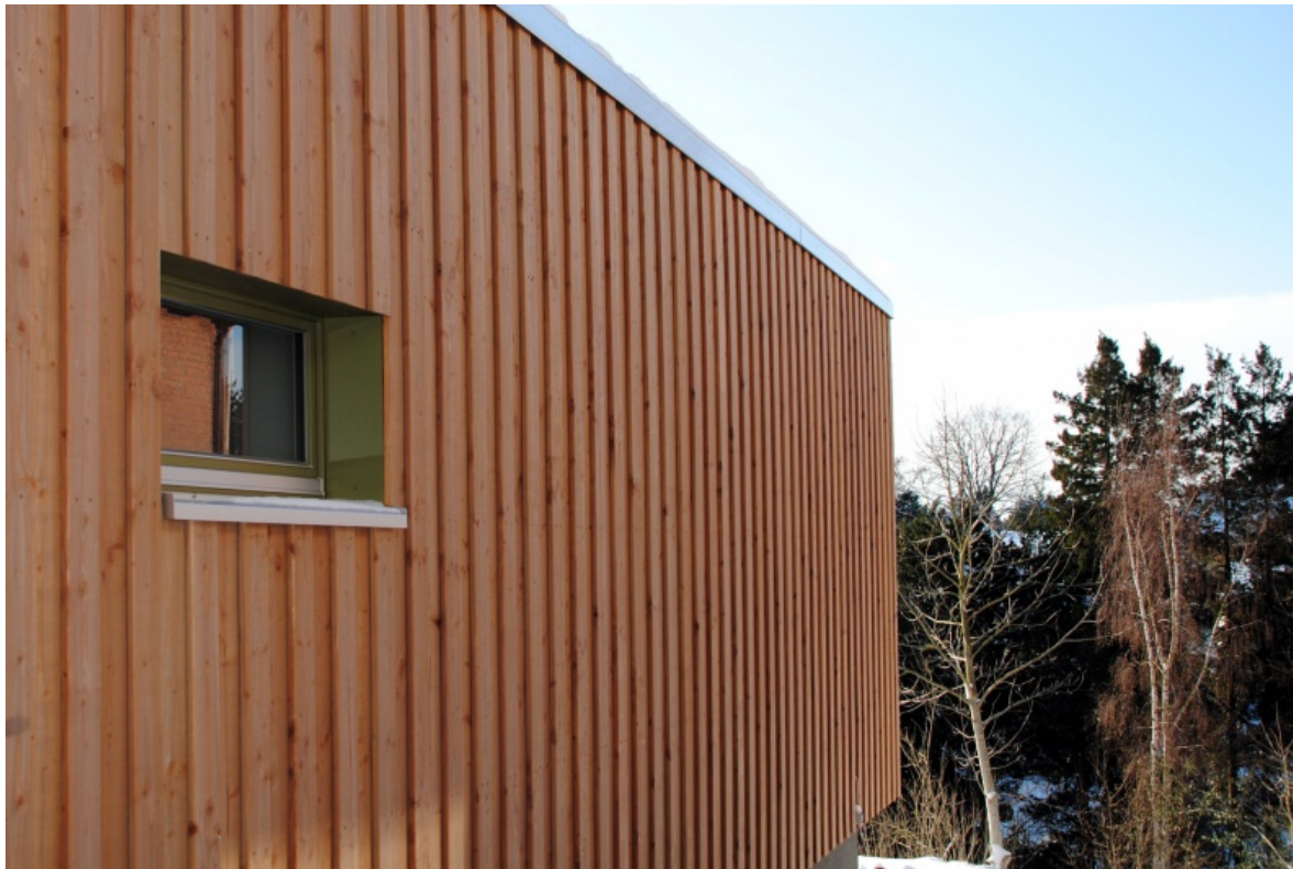
Westseite Passivhaus D48. (Foto: keenco3)
