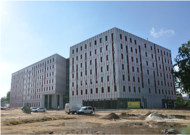
Eingangsseite Nord und Westseite
