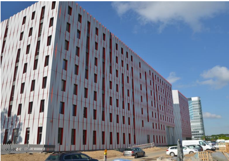
Eingangsseite Nord und Ostseite
