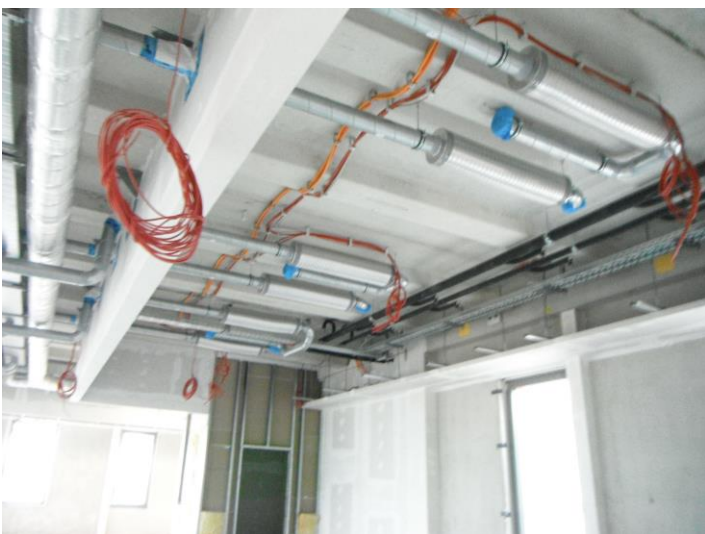
Foto von dem Einbau der Lüftungskanäle in einem Großraumbüro
