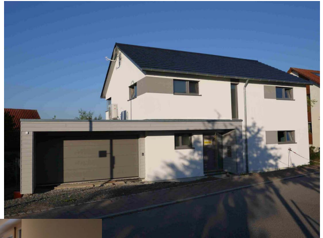
Nordostseite, erkennbar ist das Ansauggerät der Wärmepumpe auf dem Garagendach
