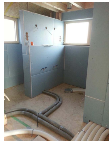
Leitungsführung auf der Holzbalkendecke (fürs EG)
