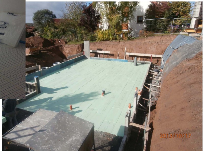
Dämmung unter der Bodenplatte
