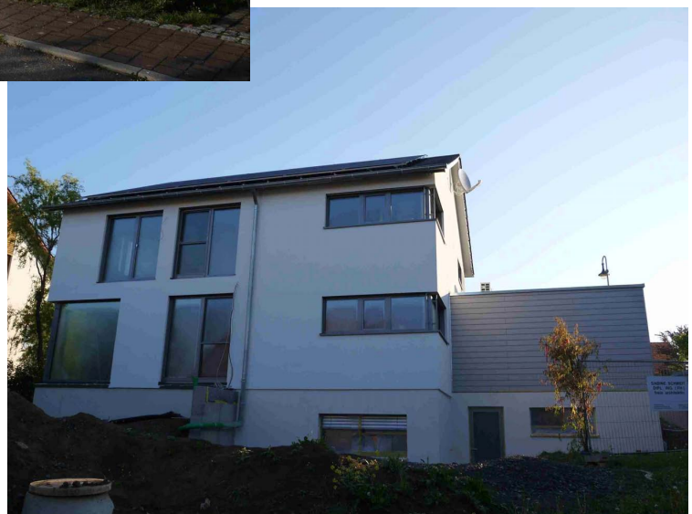
Südwestseite Passivhaus Schmidt, hier wird auf der linken Seite der Balkon angebaut
