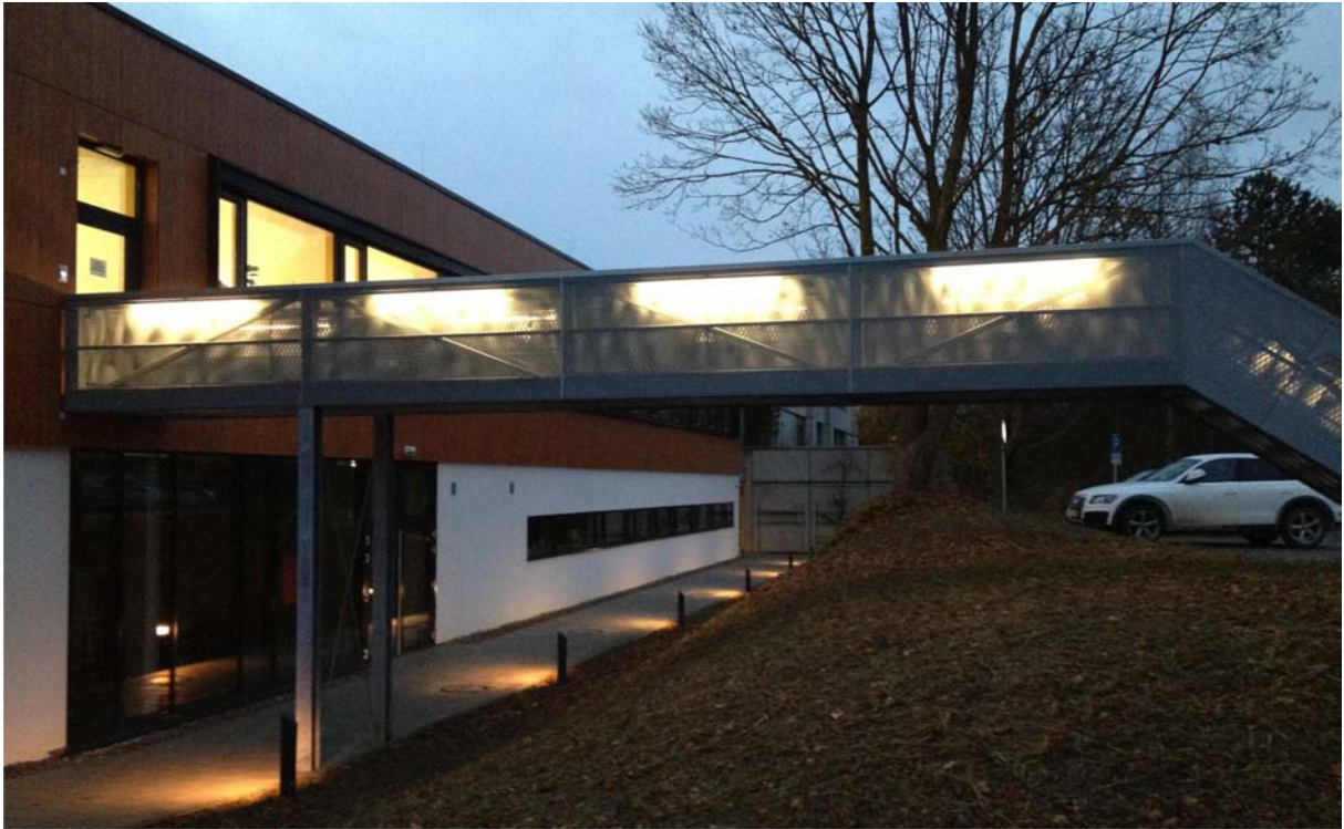
Ostansicht Steg mit Beleuchtung
