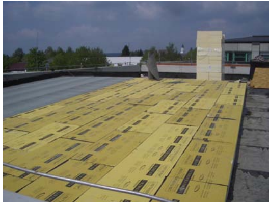
Ausführung PU-Dach-Dämmung
