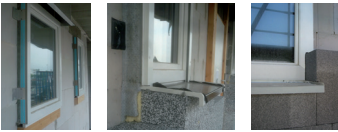
Wärmebrückenreduzierter Passivhaus-Fenstereinbau
