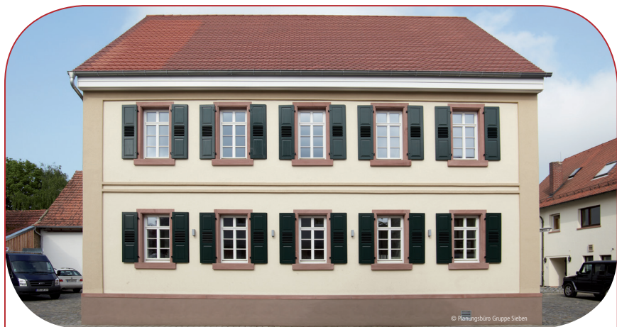
Passivhaus-Komponenten im Altbau.
