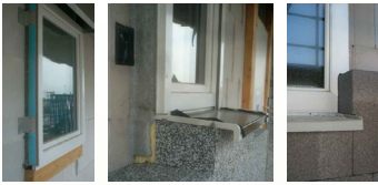
Wärmebrückenreduzierter Passivhaus-Fenstereinbau
