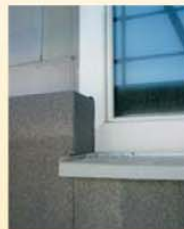
Überdämmung des Rahmens
