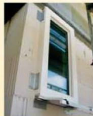
Der Fensterrahmen sitzt vor dem Mauerwerk in der späteren Dämmebene
